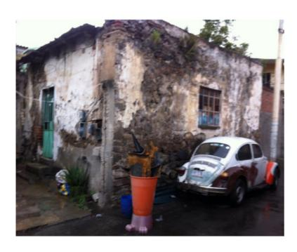
Conclusiones: El estado de conservación es malo, el aplanado existente se esta cayendo, en los muros de piedra se observa la presencia de helechos y musgo por la humedad, misma que afecta la conformación del muro de piedra, la cubierta de lámina se observa en mal estado, el edificio aún conserva los vanos originales
